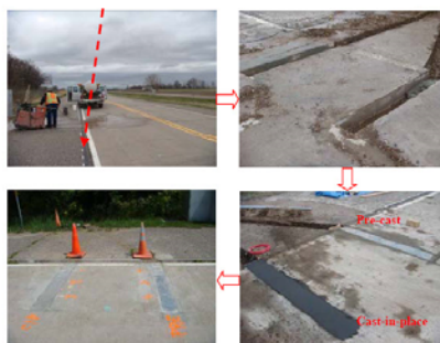
شکل ۱۵. ساخت و اجرای بتن هوشمند در محوطه مسیر آزمایشی واقع در ۴۰ کیلومتری مینیاپولیس (Yu and Kwon 2012)
