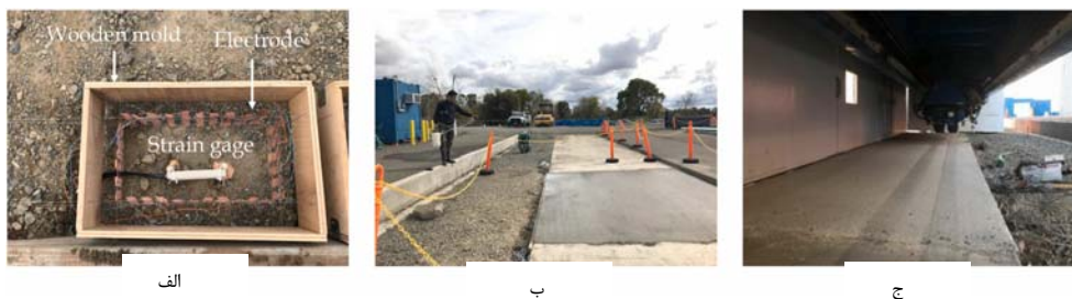
شکل ۲۰. الف) نحوه ساخت و قالب بندی نمونه‌ی بتن خودحسگر (ب) بعد از بتن ریزی و عمل‌آوری (ج) بارگذاری دال (Gupta, Y.-A. Lin, et al. 2021)
