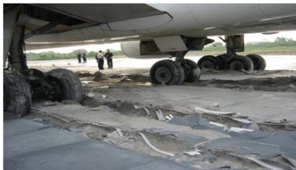
شکل ۱. خرابی باند فرودگاه ناشی از ضربه فرود (عکس از پاسکواله دیفولکو، دپارتمان هوانوردی پنسیلوانیا)
