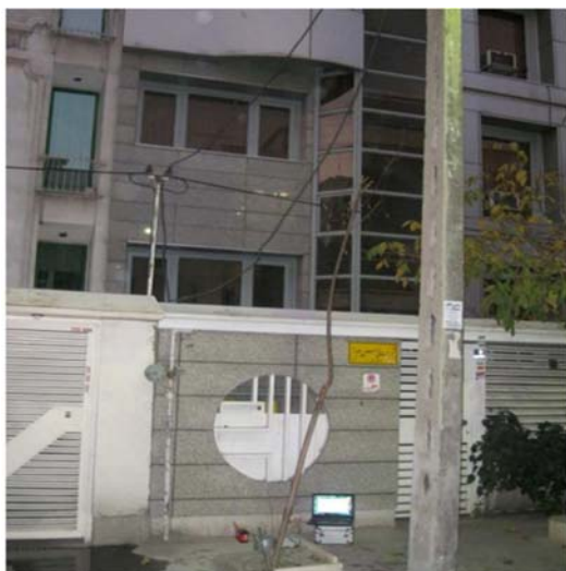
شکل ۵. اندازه گیری ارتعاش خارج ساختمان حین عبور قطار
