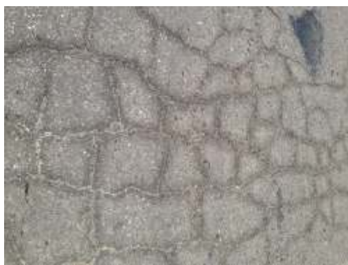
شکل ۳. ترک پوست سوسماری با شدت متوسط (محور راه‌های بین شهری - استان یزد)
