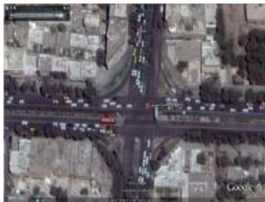
شکل ۶. نمای کلی از تقاطع شیخ صدوق
