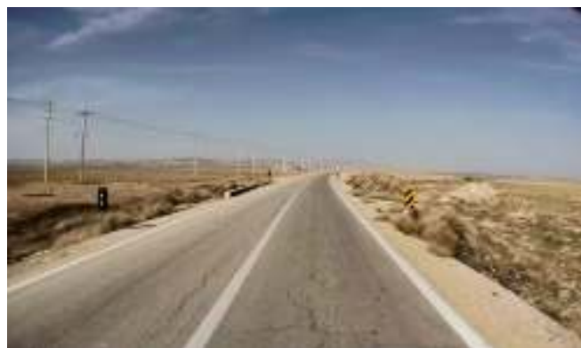
شکل ۱. نمونه‌ای از خرابی‌های روسازی موجود در محورهای استان کرمانشاه
