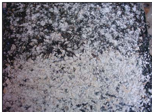
شکل ۴. بافت اندود سنگدانه‌ای گرانیت A
