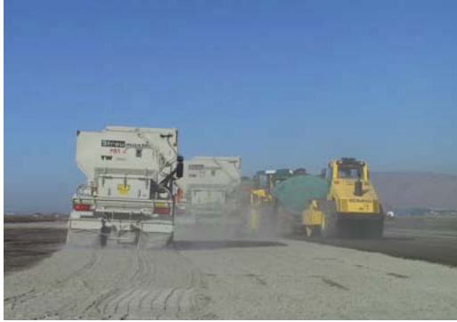
شکل ۳. دستگاه پخش کننده سیمان با ظرفیت بالا
