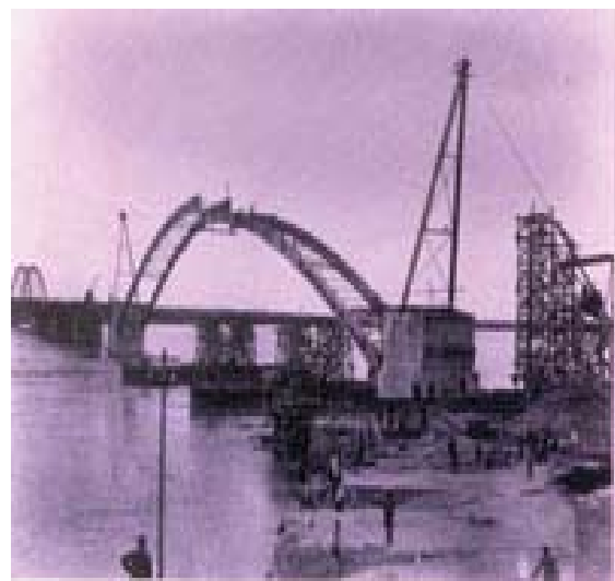
تصویر ۲. ساخت پل اهواز [۸]
