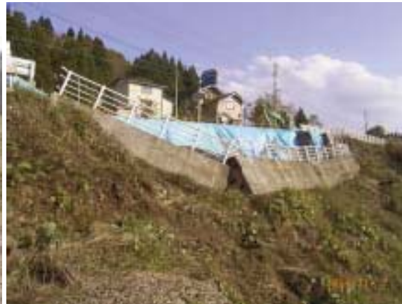
شکل ۴. نمونه خرابی دیوار و ریل راه آهن در اثر زلزله نیگاتای ژاپن در سال ۲۰۰۴
