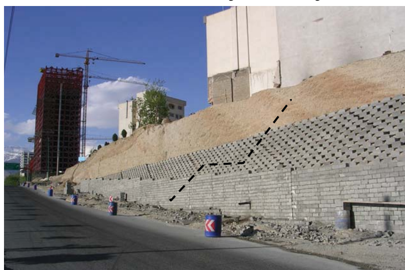
شکل ۸- ب. دیوار حایل کنار خیابان برای پایدارسازی شیب و ایمن‌سازی ساختمانهای مسکونی بالای شیب
