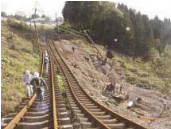
شکل ۴. نمونه خرابی دیوار و ریل راه آهن در اثر زلزله نیگاتای ژاپن در سال ۲۰۰۴
