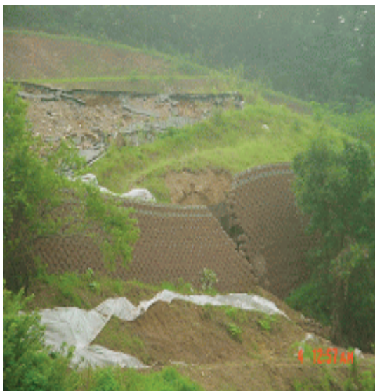
شکل ۵. نمونه خرابی دیوار حایل مسلح و جاده در اثر زمین لغزش در کره جنوبی در ژوئیه ۲۰۰۴
