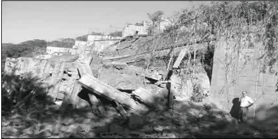
شکل ۳. نمونه خرابی دیوار و جاده در اثر زلزله السالوادور در ژانویه ۲۰۰۱
