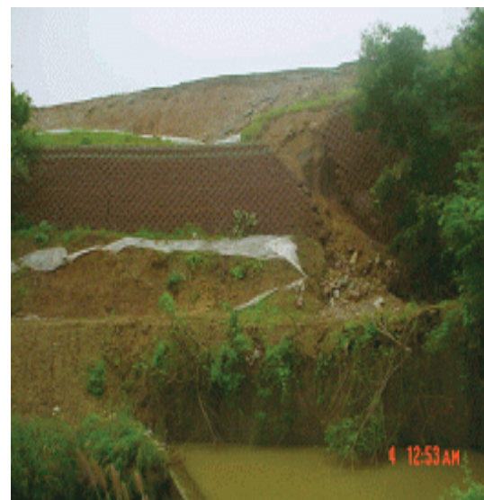
شکل ۵. نمونه خرابی دیوار حایل مسلح و جاده در اثر زمین لغزش در کره جنوبی در ژوئیه ۲۰۰۴
