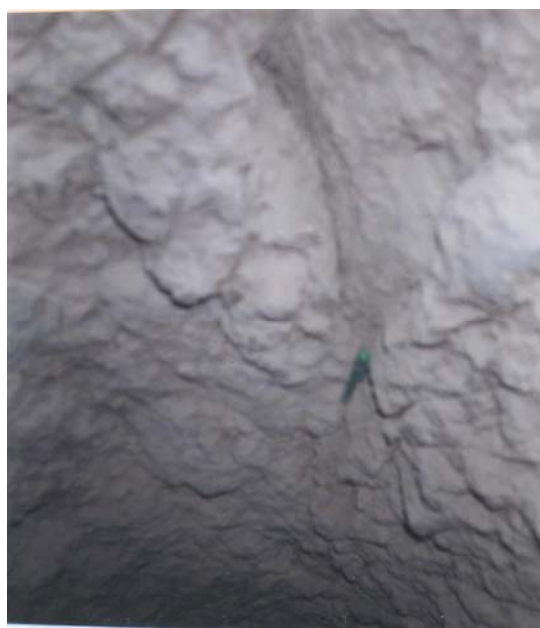
شکل ۷. تصویر شکاف در عمق شش متری در گمانه دستی نزدیک گمانه عمیق
