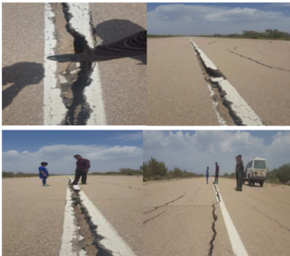
شکل ۱۱. شکاف در باند Taxi Way با احتمال جابه‌جایی مسیر حمل و نقلی از وسط
