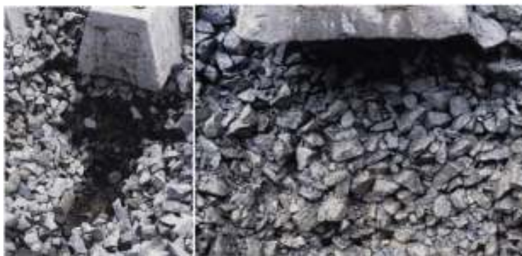
شکل ۱. نمونه‌ای از زوال و شکستگی بالاست در خط ریلی
