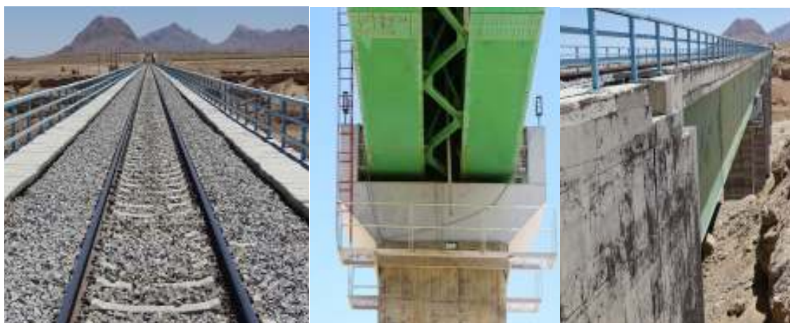
شکل ۲. سه نما از پل ایزدخواست
