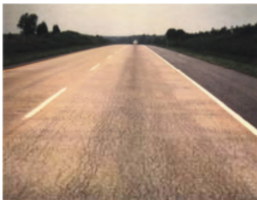
شکل ۱. رخداد ترک‌های موزاییکی در روسازی بتنی (Alkali-silica reactivity field identification handbook)
