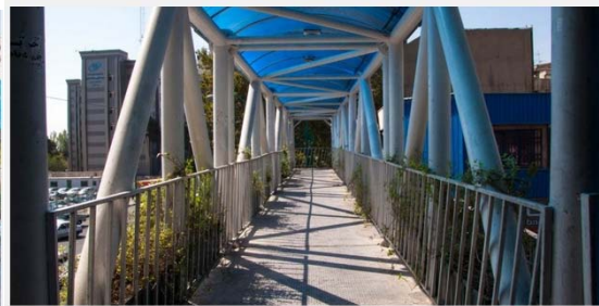
شکل ۱. نمای طولی و عرضی از یک پل عابر پیاده خرپایی
