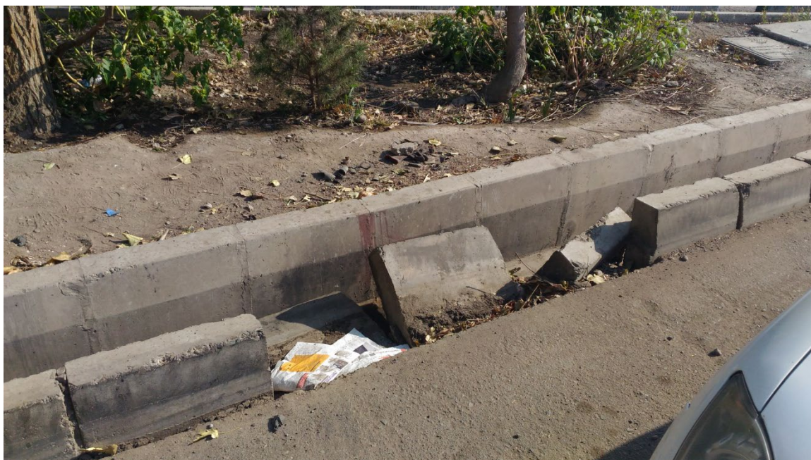
شکل ۱۱. بلوار بهار: از بین رفتن جداول
