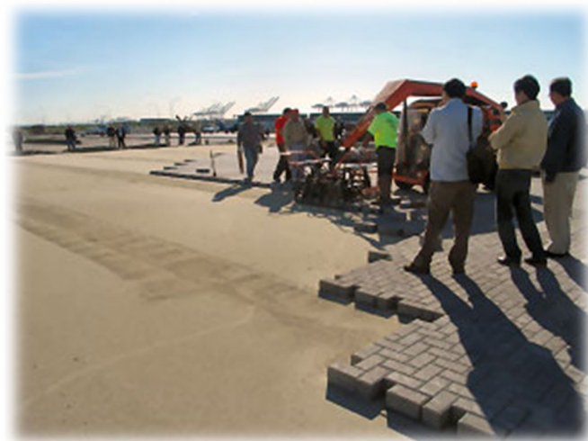
شکل ۱. اجرای مکانیزه روسازی بلوکی در بندر اوکلند در نزدیکی سانفرانسیسکو آمریکا
