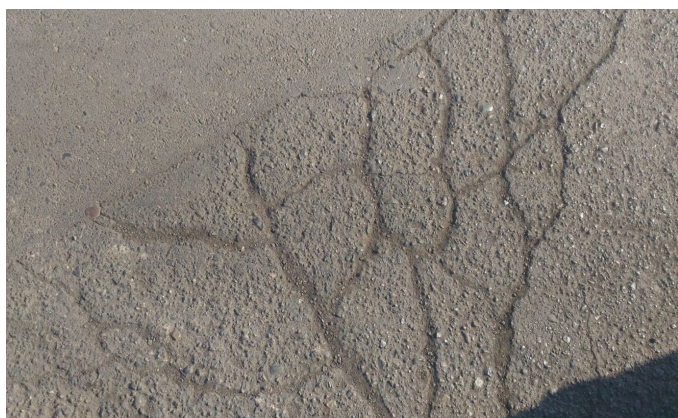
شکل ۴. بلوار طاووس: ترک‌های پوست سوسماری با شدت متوسط و زیاد
