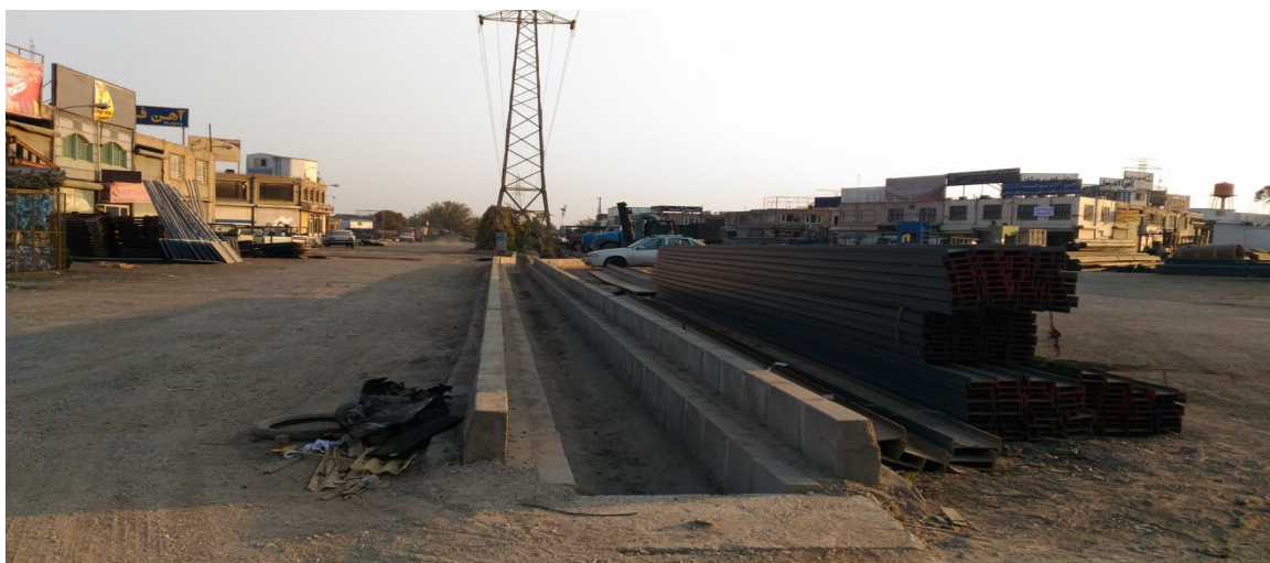
شکل ۵. بلوار بهاران: وضعیت جداول مناسب است ابتدا و انتهای آبرو بسته می‌باشد
