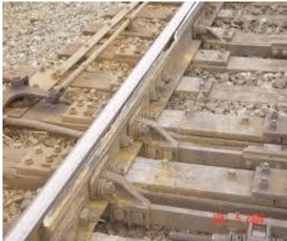
شکل 1. لب پدیدگی تیغه سوزن
