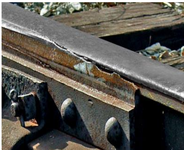
شکل 2. پریدگی تیغه سوزن
