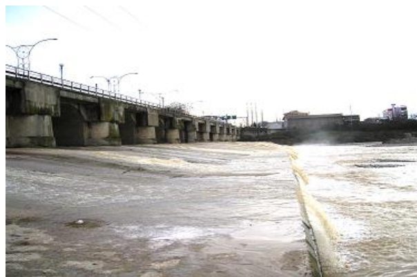
شکل 5. استفاده از رادیه و برید جهت حفاظت پل در برابر آبستگي
