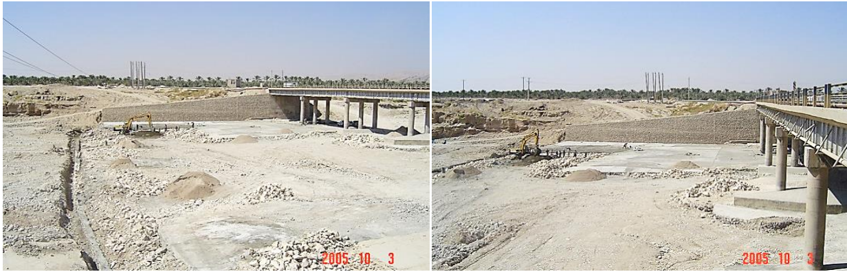
شکل 6. استفاده از رادیه و شمع- برید در پل سرقنات استان بوشهر
