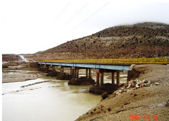
شکل 2. استفاده از سنگ‌چین برای مقابله با آبشستگی
