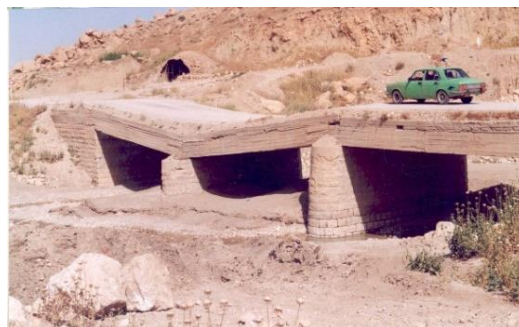
شکل 1. دو نمونه از تخریب پلها در اثر آبشستگی پایه‌های آن
