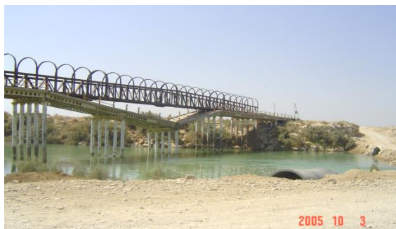
شکل 1. دو نمونه از تخریب پلها در اثر آبشستگی پایه‌های آن
