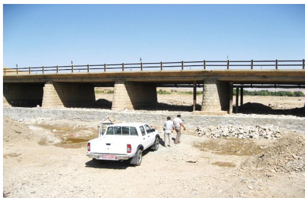
شکل 5. استفاده از رادیه و برید جهت حفاظت پل در برابر آبستگي
