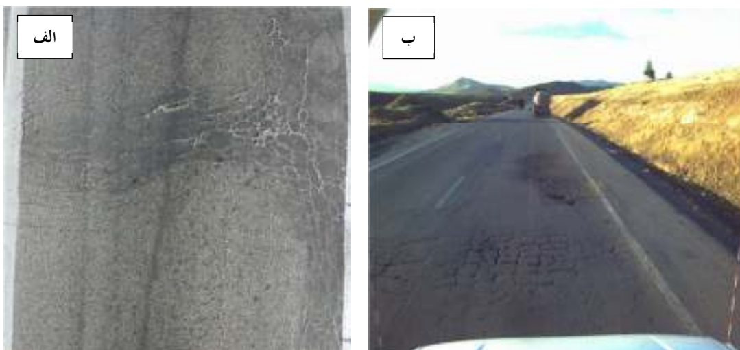
شکل ۵. تصویر برداشت شده از سطح روسازی محورهای مختلف: (الف) تصویر برداشت شده توسط دستگاه RD-3VV (شامل
