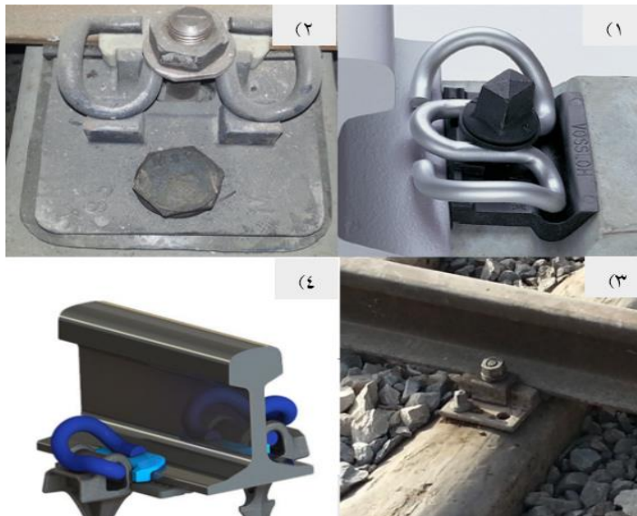
شکل 3. انواع مختلف پابندهای آزمایش شده، (1) پابند وسلو، (2) پابند KS، (3) پابند K، (4) پاندرول e-Clip
