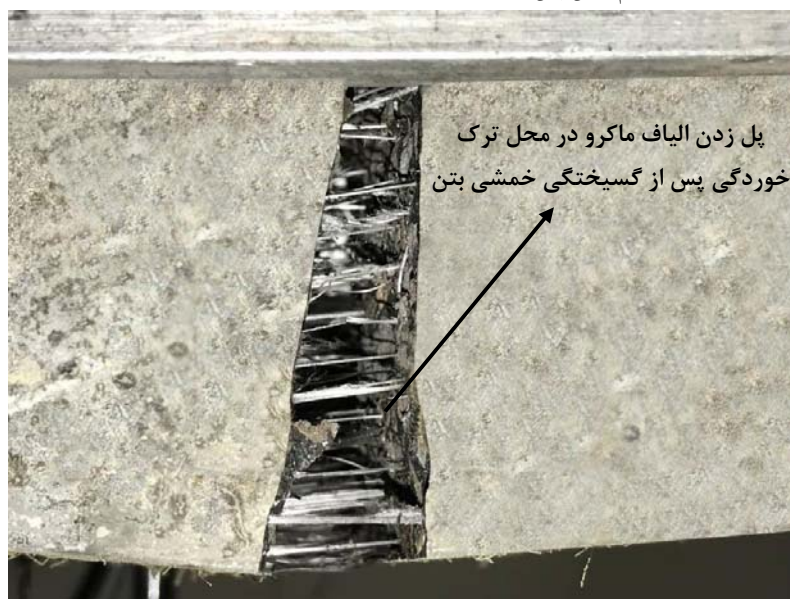
شکل ۱۳. پل زدن الیاف ماکرو در محل ترک خوردگی بتن پس از گسیختگی خمشی بتن و ادامه‌ی بارگذاری
