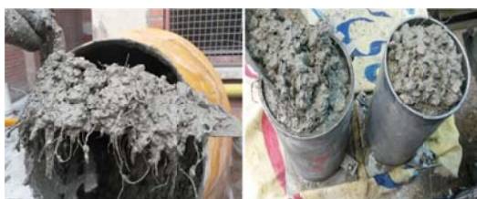
شکل ۴. ساخت نمونه‌های استوانه‌ای جهت ارزیابی مقاومت فشاری بتن مطابق با استاندارد ASTM C39
