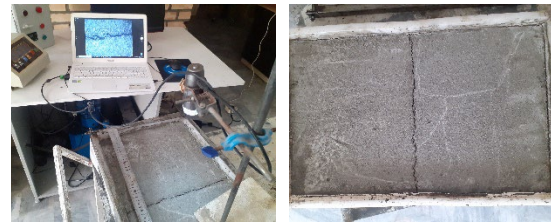
شکل ۷. دال بتنی ترک خورده و تهیه ی تصویر میکروسکوپی از دال بتنی
