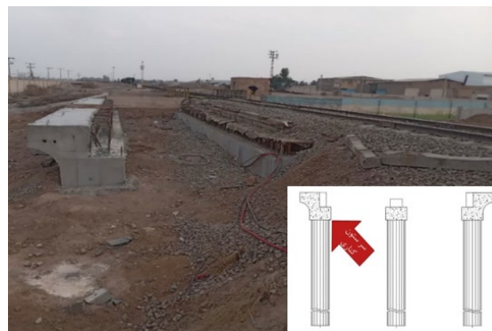
شکل ۵. اجرای سرستون در محل پروژه
