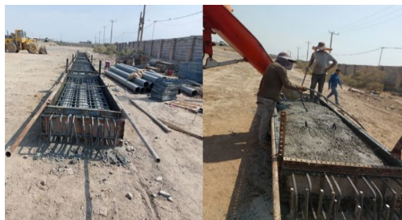
شکل ۶. اجرای دال پیش ساخته در کارگاه
