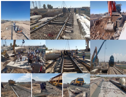
شکل ۷. سلسله عملیات‌های مربوط به نصب خط پس از اجرای عرشه
