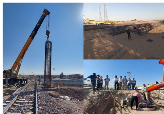
شکل ۳. اجرا و بتن ریزی شمع‌ها
